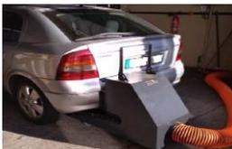
Kit W-PAO-HELL3000 commercialisé par LG Distribution : Ventilation générale mise en place en complément d'un captage localisé
